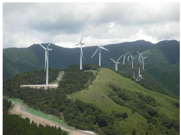
静岡県賀茂郡東伊豆町・河津町の東伊豆風力発電所
