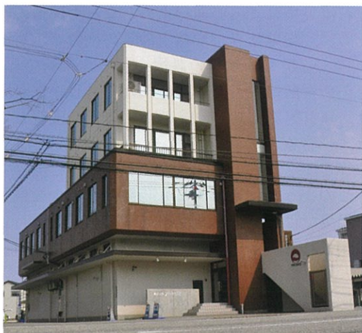
写真 1.1 平成 29 年 4 月移転開設の富山本社
