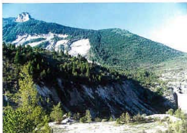
写真-1 地すべり崩土によって埋め尽くされたバイオントダム。右下にダムがあり、左上部に露出したすべり面が見える。
