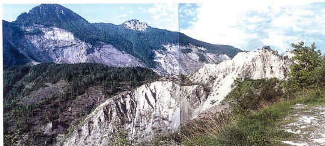
写真-3 すべり面の露出したバイオント地すべり斜面(遠景)と峡谷を埋め尽くした地すべり崩土の上流側先端部(前景)。
