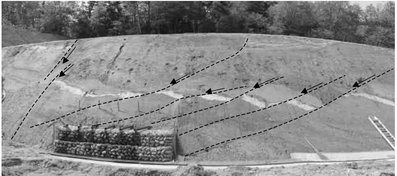
写真 - 2 地すべりによって形成された階段断層 (図 - 3 中央上部)
