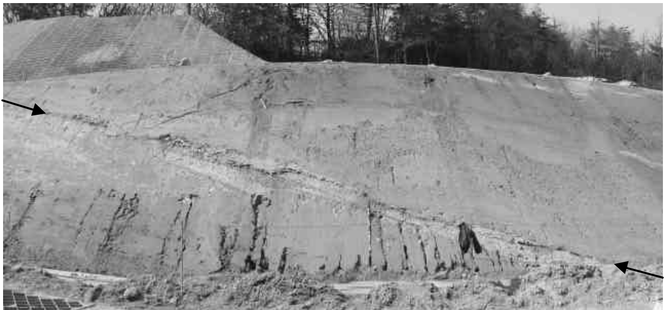
写真 - 1 Bブロックすべり面(図 - 3の左上半部)
